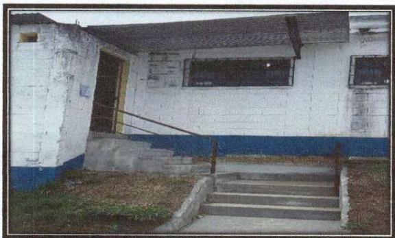
Foto 9: MANTENIMIENTO ELABORACIÓN Y FUNDICIÓN DE GRADERIO, INSTALACIÓN DE PASAMANOS, ELABORACIÓN E INSTALACIÓN DE PUERTA Y TECHO EN ÁREA AUXILIAR DE ENTRADA.
