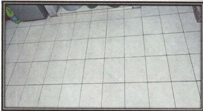
Foto 1: COMPRA E INSTALACIÓN DE PISO EN COCINA
