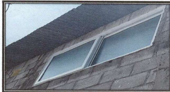
Foto 8: MANTENIMIENTO Y ELABORACIÓN DE VENTANA DE PVC EN SALON DE ACTIVIDADES MÁS INSTALACIÓN.
