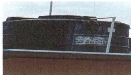
Foto 10: SUSTITUCIÓN DE ACCESORIOS PARA DEPOSITO DE AGUA QUE SE INSTALO EN ÁREA DE COCINA.
