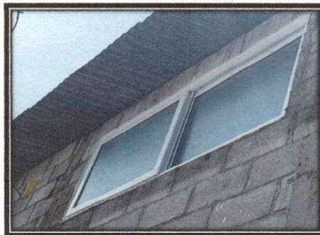
Foto 8: MANTENIMIENTO Y ELABORACIÓN DE VENTANA DE PVC EN SALON DE ACTIVIDADES MÁS INSTALACIÓN.
