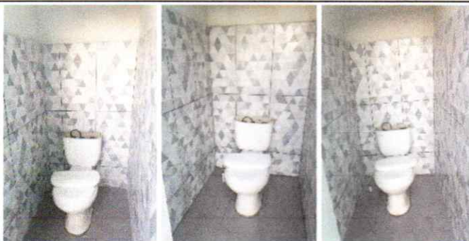
Foto 6: Sanitarios con azulejo y piso nuevo
