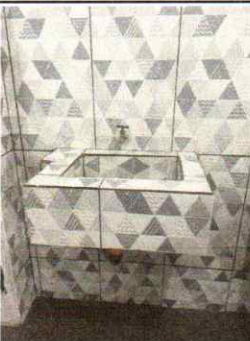
Foto 5: Lavamanos con azulejo nuevo
