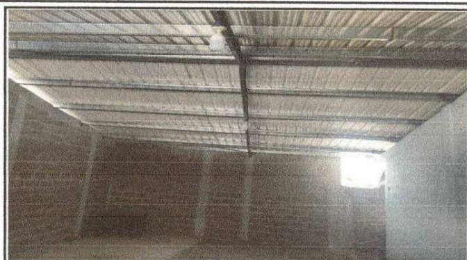
Foto 2: Esta imagen nos muestra la sustitución de paredes y techo de lamina en el salón de clases de la Escuela Oficial Rural Mixta Jornada Matutina.
