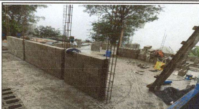
Foto 2: Esta Imagen nos muestra como fue sustituida las paredes de lamina de sinc por paredes de concreto de un salón de clases de la Escuela Oficial Rural Mixta Jornada Matutina del Caserio Los Ajvíx.
