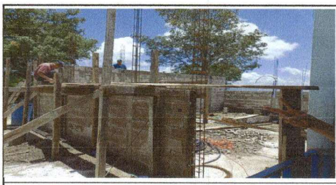
Foto 6: Esta imagen nos muestra el avance de sustitución de lamina de sinc por paredes de concreto de un salón de clases para la Escuela Oficial Rural Mixta Jornada Matutina.
