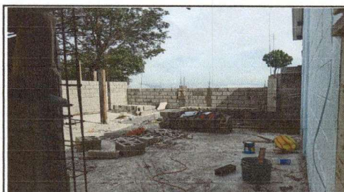
Foto 4: Esta imagen se puede observar como se sustitulleron todas las paredes de lamina de sinc por paredes de concreto para un salón de clases.
