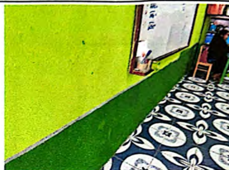
Foto 8: Muro resanado y con aplicación de pintura.
