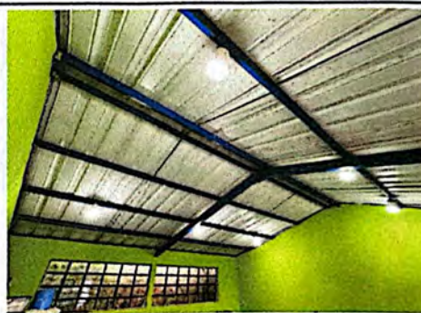
Foto 4: Suministro e instalación de sistema eléctrico de iluminación
