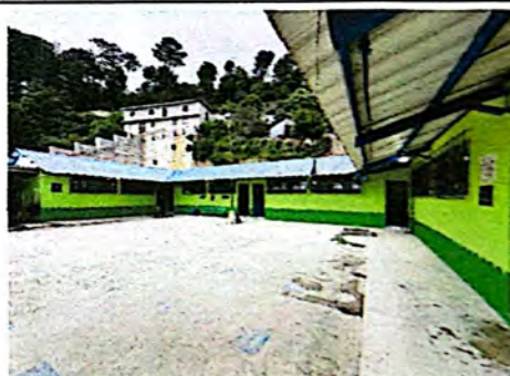
Foto 10: Aplicación de pintura general en establecimiento
