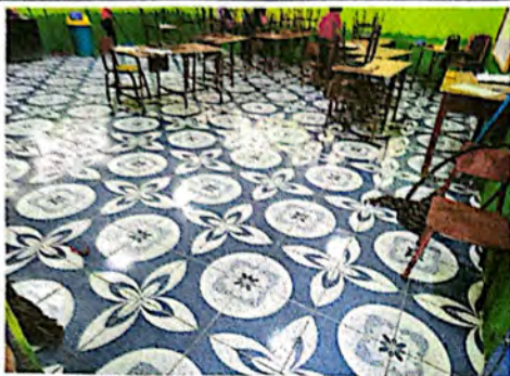
Foto 1: Suministro y aplicación de piso cerámico.
