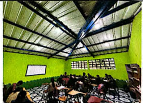
Foto 6: Instalación de luminarias, incluye cambio de cableado, ductos, interruptores y tomacorrientes.
