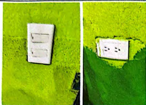
Foto 7: Suministro e instalación de interruptores y tomacorrientes.
