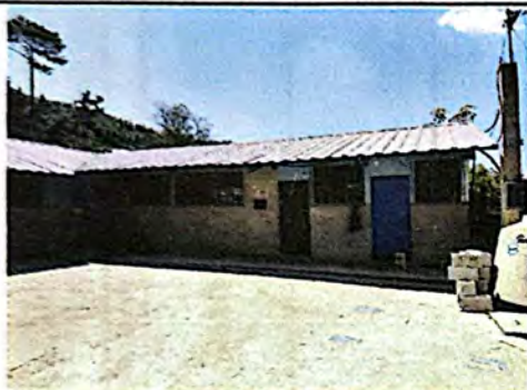
Foto 9: Establecimiento previo a la aplicación de pintura.
