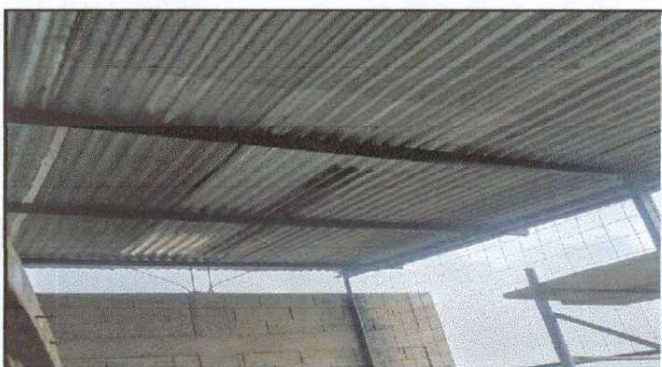
Foto 3: Instalación de estructura Metálica
