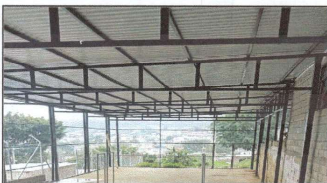
Foto 4: Instalación de estructura Metálica en el patio de juegos (cancha)
