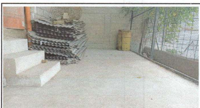
Foto 6: Reparación y fundición de concreto en área de juego.
