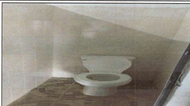
Foto 2: Instalación de azulejo en los baños
