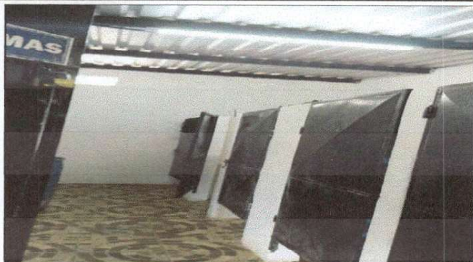
Foto 1: Repello de paredes de los baños
