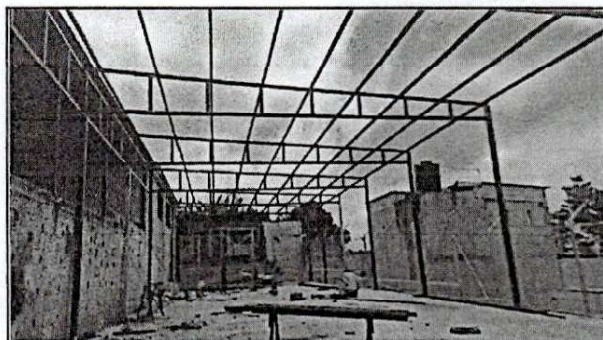
Foto 4: Instalación de estructura Metálica en el patio de juegos (cancha)
