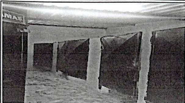
Foto 1: Repello de paredes de los baños
