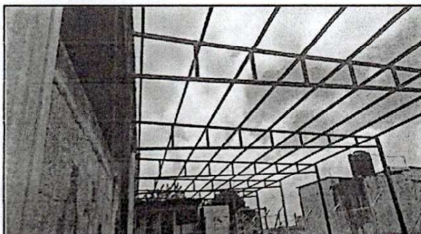
Foto 3: Instalación de estructura Metálica
