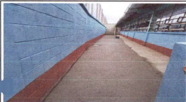
Foto1: Fundición de banqueta finalizado.
