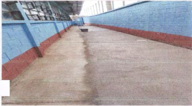
Foto1: Terminado de pintura en callejón.
