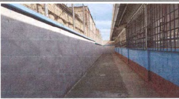
Foto 4: Finalización de fundición de banqueta.
