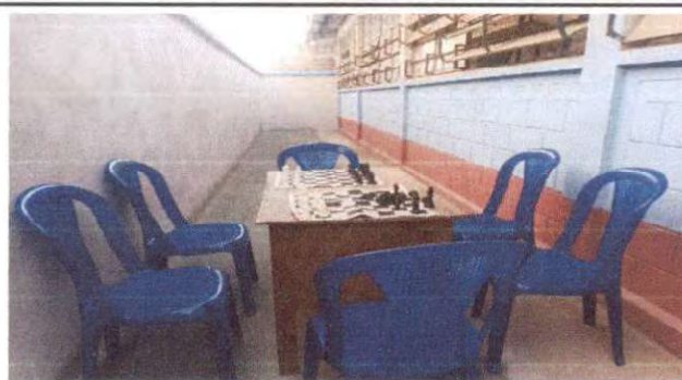
Foto 2: Fundición de banqueta de callejón finalizado.
