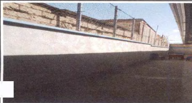
Foto1: Finalización de repello de pared.
