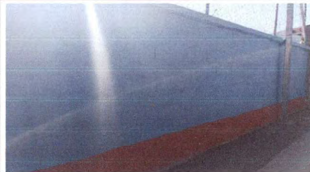
Foto 2: Terminado de pintura patio principal.
