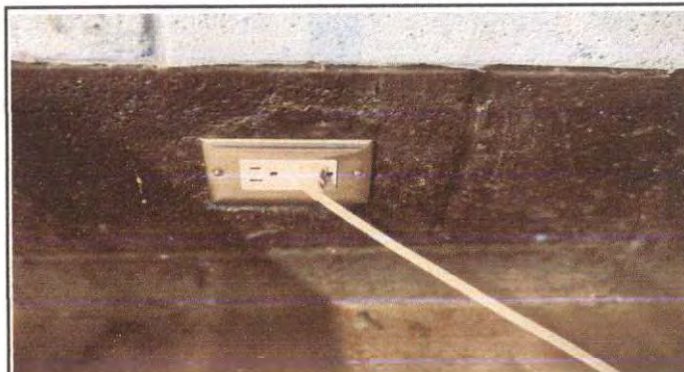
Foto 4: Instalacion de tomacorrientes en salones de clases y cocina.
