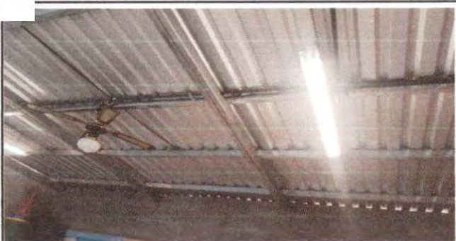
Foto 5: Cambio de lámina acanalada por lámina troquelada alucin calibre 26, visto de la parte interior..
