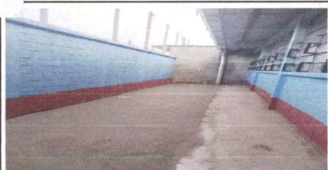
Foto 5: Fundición de banqueta.
