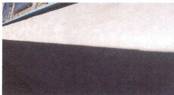
Foto 2: Finalización de repello de pared.
