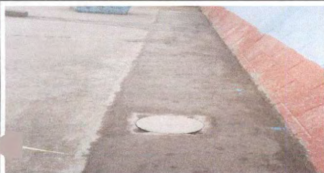
Foto 1: Finalización reposadera para aguas fluviales.
