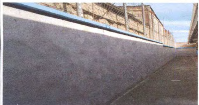
Foto 3: Repello de pared terminado.
