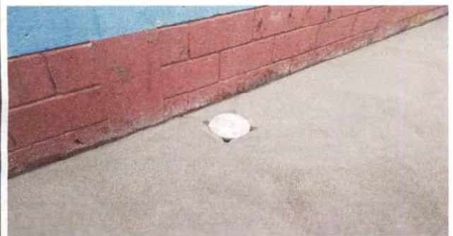
Foto 3: Colocación de tapadera para reposadera.
