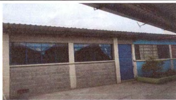
Foto 2: Finalización del proyecto cambio de lámina acanalada por lámina troquelada alucin calibre 26.
