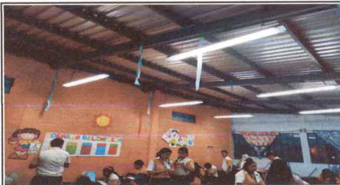
Foto 2: Revision de circuitos de iluminacion. Instalacion de lamparas en seis salones de clases.
