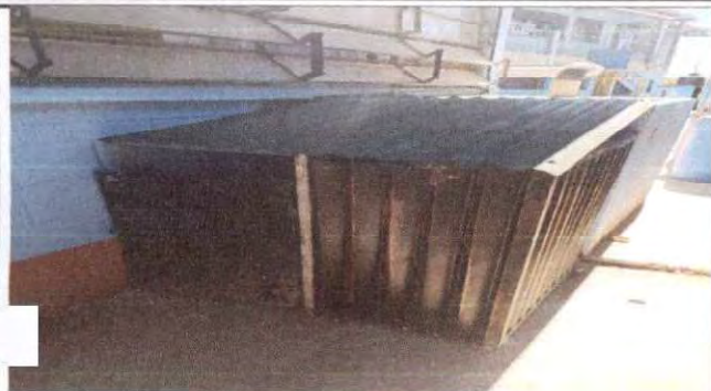
Foto1: Finalización de cubierta de metal para protección de bomba de agua.
