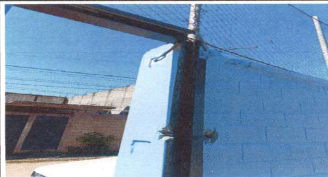
Foto 4: Finalización pintura de marco de portón.
