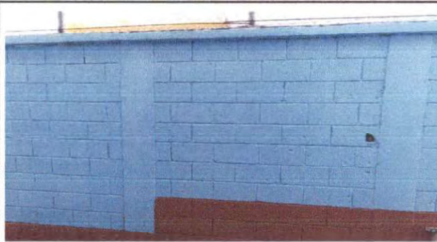
Foto 4: Terminado de pintura segundo patio.
