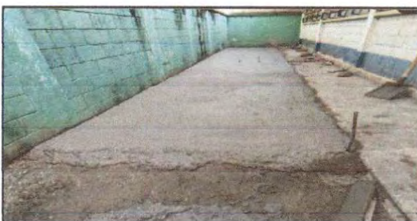
Foto 6: Fundición de banqueta.
