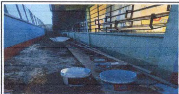
Foto 3: Aplicación de pintura de socalo.
