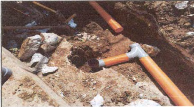
Foto 4: Unión de tubos pvc para aguas fluviales.
