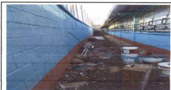
Foto 4: Aplicación de pintura en los callejones.
