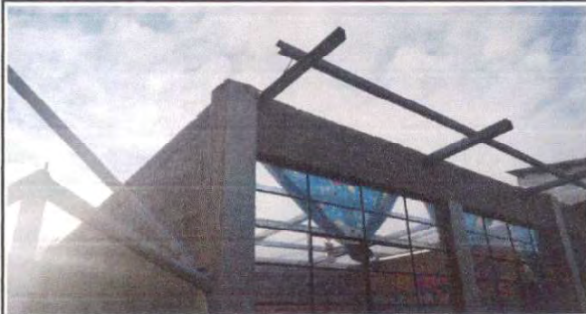
Foto 2: Retiro de lámina acanalada por lámina troquelada alucin calibre 26.
