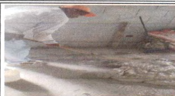
Foto 2: Preparación de material aplicación de repello.
