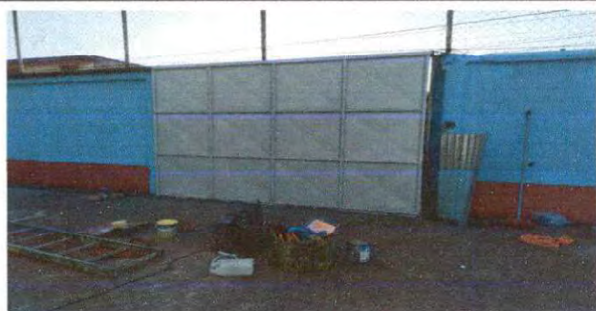
Foto 5: Aplicación de pintura para capa protectora.
