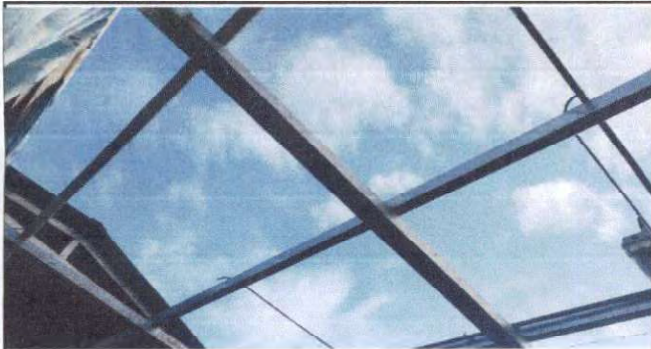
Foto 3: Retiro total de lámina acanalada.
