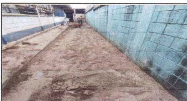
Foto 4: Relleno de zanja y nivelación de terreno.
