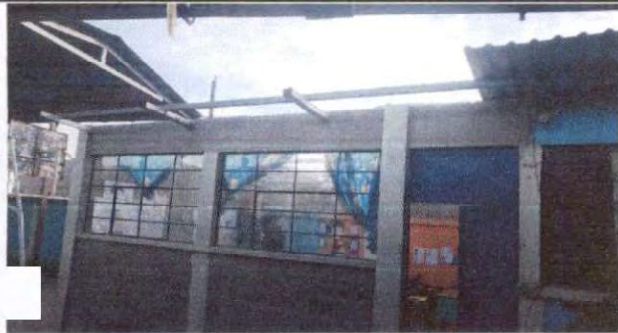
Foto1: Inicio de cambio de lámina acanalada por lámina troquelada alucin calibre 26.
