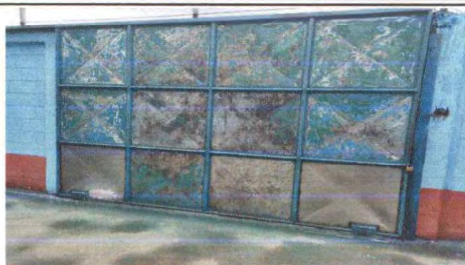
Foto 2: Cambio de lámina en dos secciones del portón.
