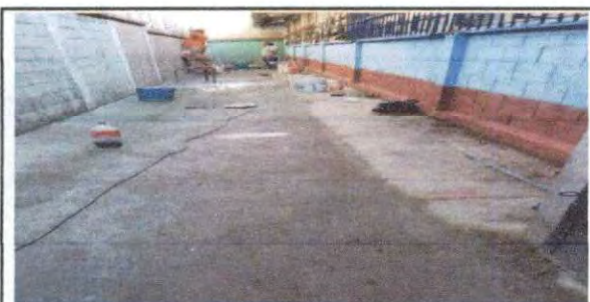
Foto 5: Aplicación de repello.
