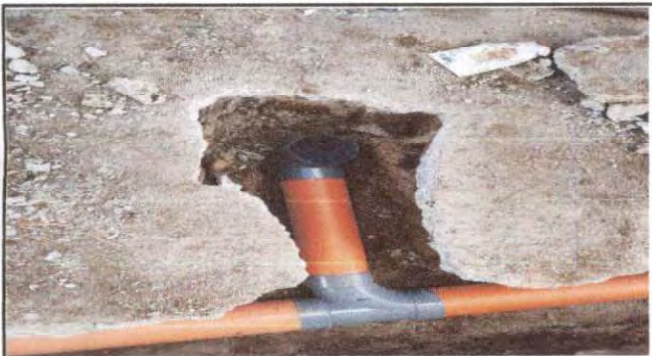
Foto 3: Colocación de tubo pvc para reposadera.
