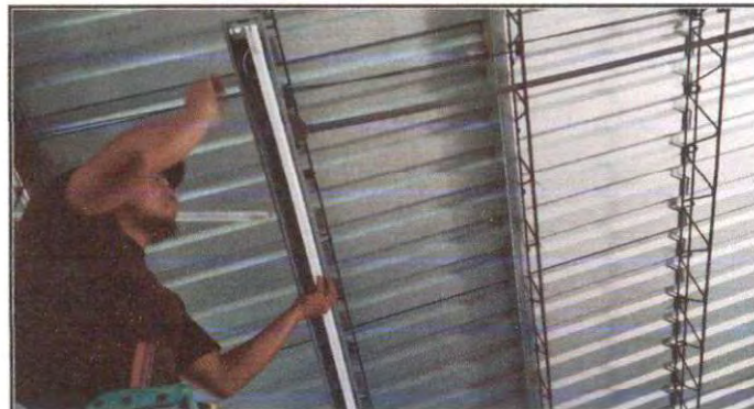
Foto 4: INSTALACION DE LAMPARAS LED
