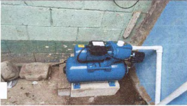
Foto1: Colocación de nueva bomba de agua.
