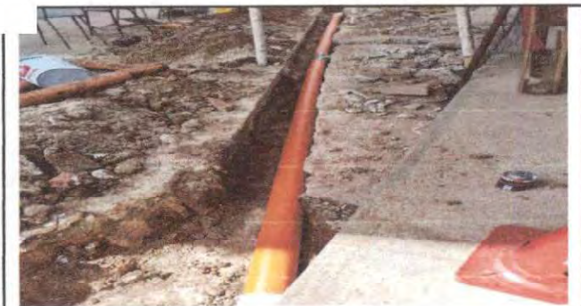
Foto 5: Colocación de tubo Pvc para aguas fluviales.
