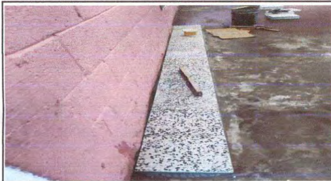
Foto 3: Iniciando a colocar piso en AULA 1
