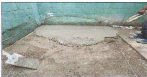
Foto 5: Inicio de fundición de banqueta.
