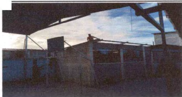
Foto 5: Proceso de retiro de lámina acanalada.
