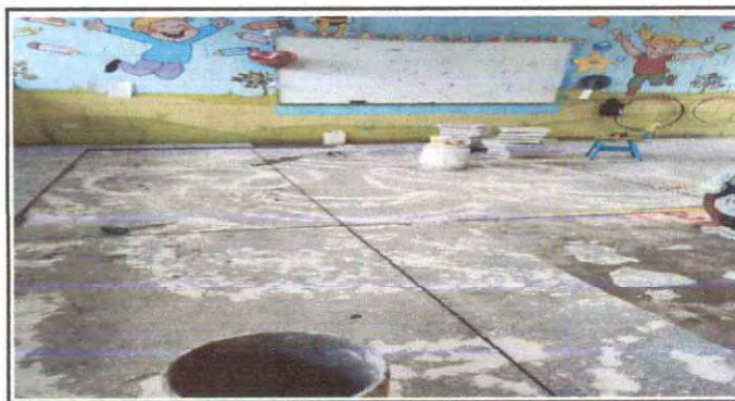
Foto 5: Avance de colocacion de piso
