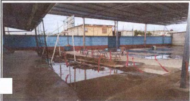
Foto1: Elaboración de zanja para aguas fluviales.
