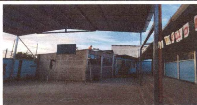
Foto 4: Avance de retiro de lámina acanalada.
