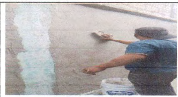
Foto 4: Aplicación de repello.
