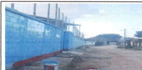
Foto 6: Aplicación de pintura parte exterior del establecimiento.
