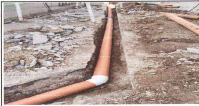
Foto 6: Ensamblado de tubo pvc.
