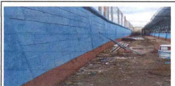
Foto 5: Aplicación de pintura parte superior y socalo.
