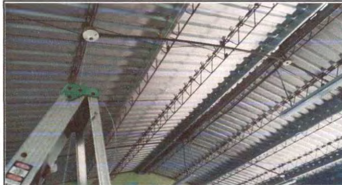
Foto 2: MEJORAMIENTO DE ILUMINACION EN SALONES SEGUNDO NIVEL.
