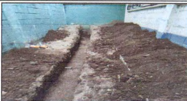
Foto 2: Elaboración de zanja para tubería de drenaje.
