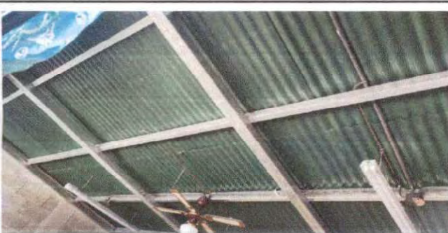
Foto 3: Mejoramiento de ambiente.
