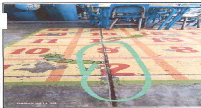
Foto 5: AULA PARA INSTALACION DE PISO GRANITO.
