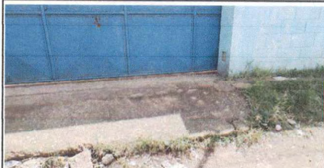
Foto Mantenimiento de portón principal.
