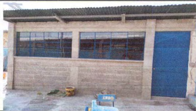
Foto 1: Cambio de lámina acanalada por troquelada.
