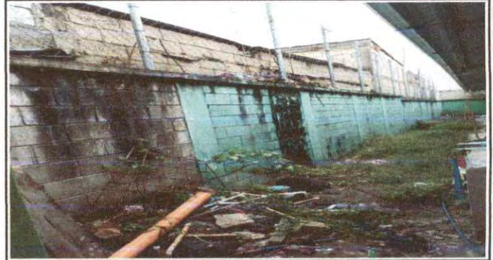
Foto 4: SELLADO DE MURO, REPELLO Y CERNIDO DE PARED .
