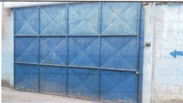
Foto1: Mantenimiento de portón principal.
