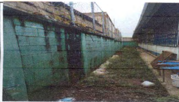
Foto 3: Evitar la humedad en las paredes.
