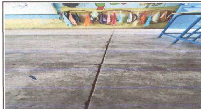
Foto 4: EL MANTENIMIENTO DE INFRAESTRUCTURA, CONTRIBUYE A LA EFICIENCIA INTEGRAL. AREA PARA INSTALAR PISO EN AULA 2
