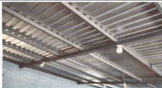
Foto 3: Instalación de lámparas nueva.
