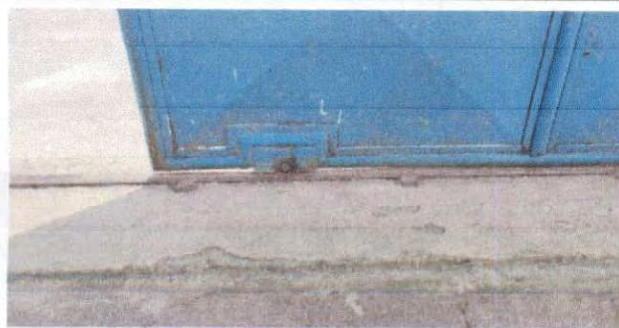
Foto 3: Mejorar la accesibilidad.
