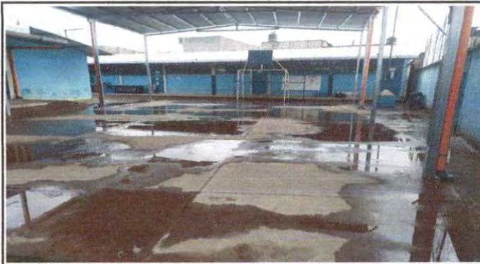
Foto 2: Conducción de drenajes como corresponde, evitara charcos en área deportiva
