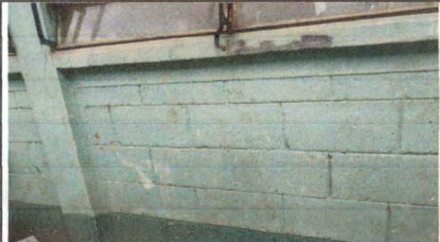
Foto 4: Mejoramiento de la pintura.
