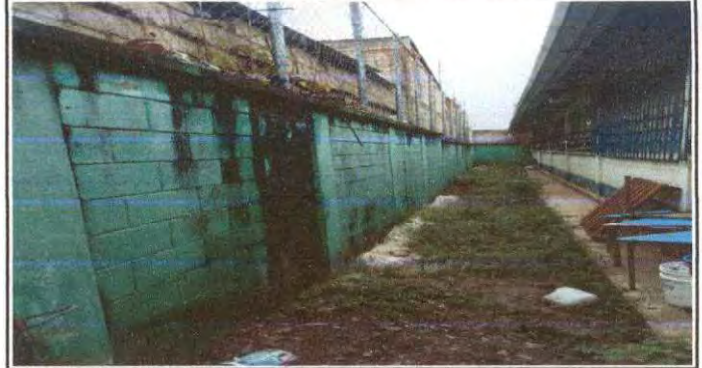
Foto 2 Mantenimiento de pared con fondos de remozamiento 2024 centro educativo EORM COLONIA BENDICION DE DIOS JM
