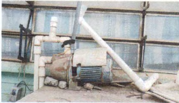
Foto1: Sustrución de bomba por antigüedad.
