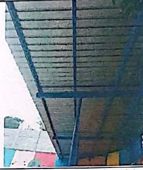
Foto 2: Estructura de techo de graderíos lijada y pintada.
