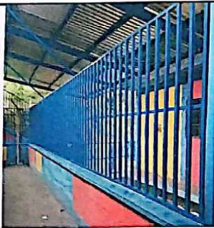
Foto 5: Limpieza, lijado para eliminar óxido y aplicación de pintura anticorrosiva, mejorando la durabilidad y la seguridad.
