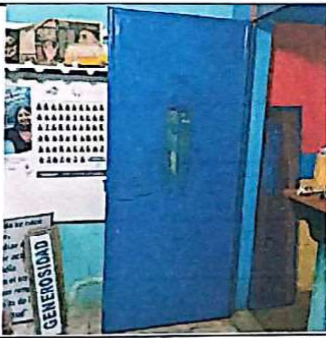
Foto 3: Mantenimiento a las puertas de los salones, se lijaron partes oxidadas y las volvieron a pintar.
