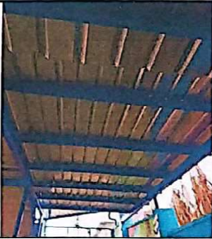
Foto 1: Estructura de techo de la entrada remozada. Costaneras lijadas y pintadas.
