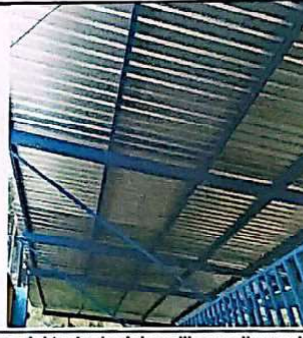
Foto 4: La estructura del techado del pasillo que lleva a la aulas, lijada y pintada.
