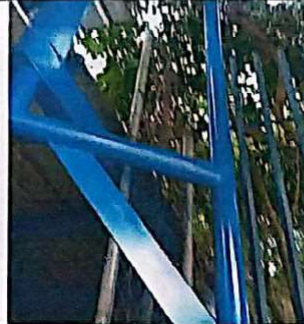
Foto 6: Parales metálicos con limpieza profunda, eliminación de óxido mediante lijado y pintura anticorrosiva, reforzando la resistencia, estética y funcionalidad del techo.
