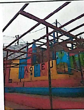
Foto 4: La estructura del techado del pasillo que lleva a la aulas, lijada y pintada.
