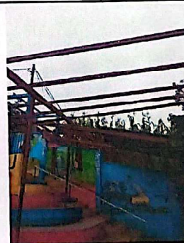
Foto 6: Parales metálicos con limpieza profunda, eliminación de óxido mediante lijado y pintura anticorrosiva, reforzando la resistencia, estética y funcionalidad del techo.
