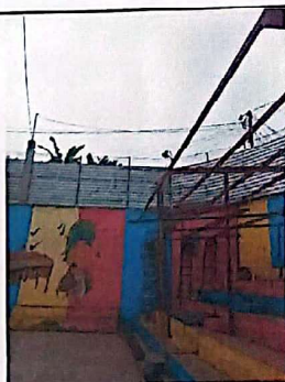
Foto 5: Limpieza, lijado para eliminar óxido y aplicación de pintura anticorrosiva, mejorando la durabilidad y la seguridad.
