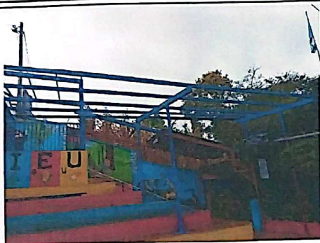
Foto 1: Estructura de techo de la entrada remozada. Costaneras lijadas y pintadas.
