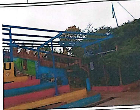
Foto 2: Estructura de techo de graderíos lijada y pintada.
