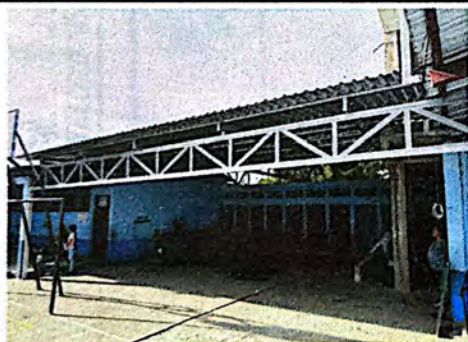
Foto 9: Techo de lámina para protección de baños.
