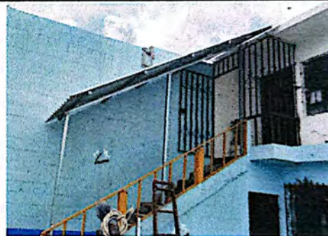
Foto 10: Instalación de techo para protección de ingreso a dirección.
