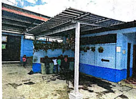
Foto 7: Instalación de estructura para cubrir la pileta.
