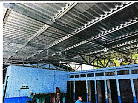
Foto 8: Suministro e instalación de estructura metálica de soporte para techo en área de baños.
