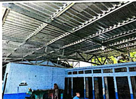
Foto 10: Instalación de lámina troquelada + instalación de luminarias.
