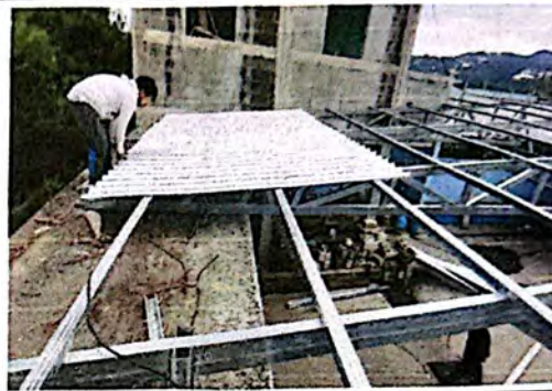
Foto 8: Suministro e instalación de lámina troquelada.
