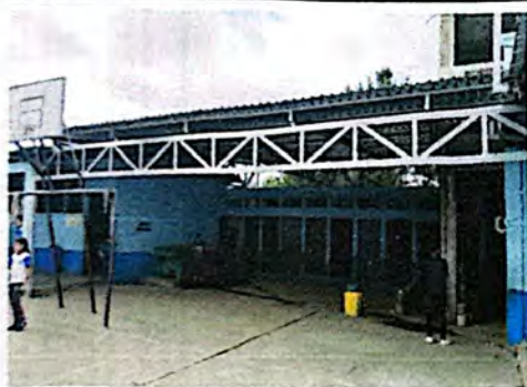
Foto 9: Techo de lámina
