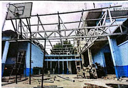
Foto 7: Instalación de estructura para techo.
