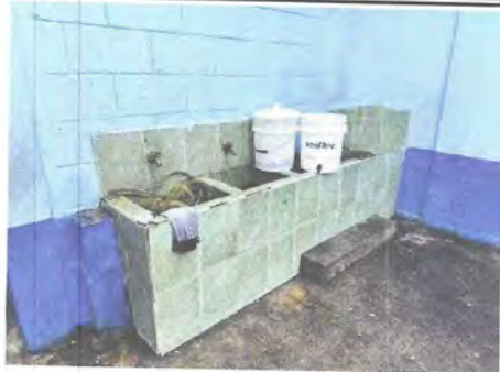
Foto 7: Se debe quitar el piso existente y forrar de azulejo la pileta, además de cambiar los chorros.
