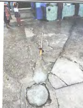
Foto 8: El drenaje de la pileta se encuentra de manera superficial por lo que se deberá mejorar
