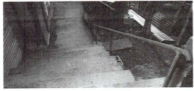
Foto 6: Instalación de pasamanos.
