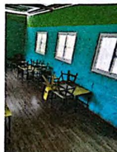
Foto 10: Piso en salón de clases.
