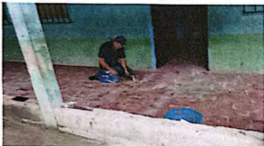
Foto 7: Trabajos de demolición.
