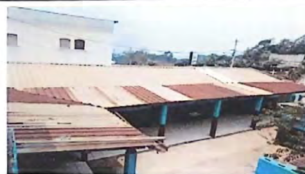
Foto 4: Derivado a la oxidación y filtración del agua del techo, es necesario el cambio de láminas troqueladas.
