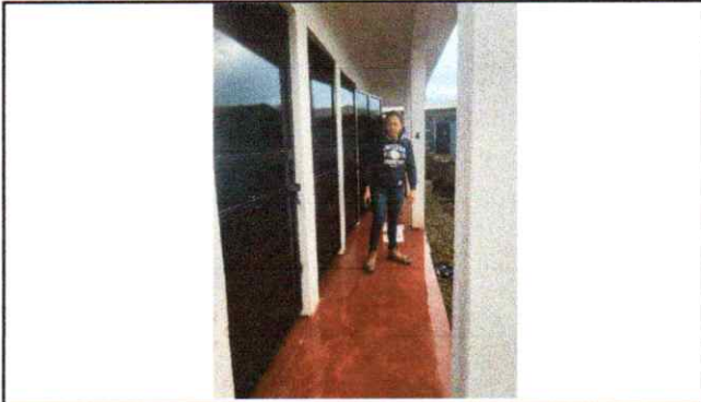
Foto 1: Evaluadora de campo, observando el contrapiso de concreto en el área de sanitarios
