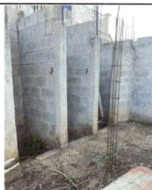
Foto 4: Módulo A, continuación y mejoramiento de muros en baños
