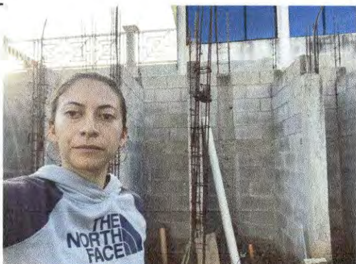
Foto 9: Módulo A, continuación y mejoramiento de muros en baños
