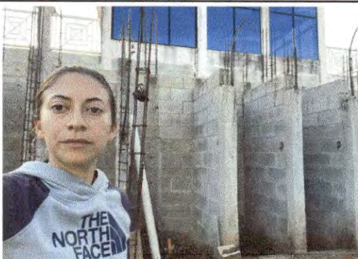
Foto 5: Módulo A, continuación y mejoramiento de muros en baños
