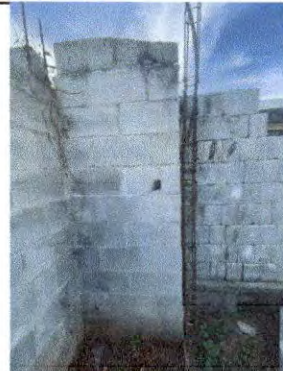
Foto 6: Módulo A, continuación y mejoramiento de muros en baños
