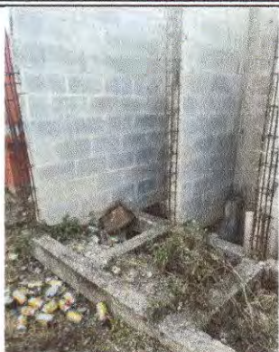
Foto 7: Módulo A, continuación y mejoramiento de muros en baños
