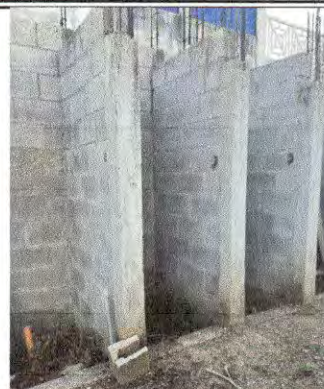
Foto 8: Módulo A, continuación y mejoramiento de muros en baños
