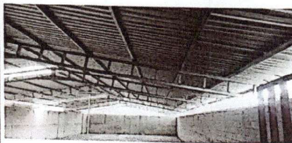
FOTO 2: CAMBIO DE LAMINA
