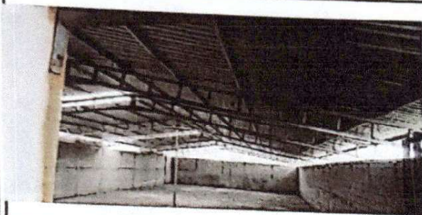
Foto1: ESTRUCTURA DE TECHO
