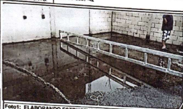
Foto 1: ELABORANDO ESTRUCTURA DE TECHO
