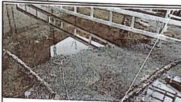
FOTO 2_ ELABORANDO ESTRUCTURA DE TECHO
