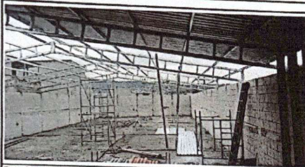
Foto 3: TECHADO DE LAMINA Y ESTRUCTURA
