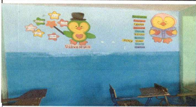
Foto 1: Cambio de repello en la tercer aula
