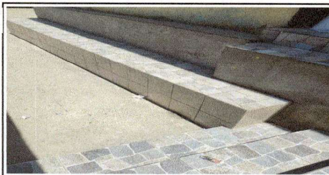
Foto 5: Instalación de pizo cerámico antideslizante de las gradas del patio
