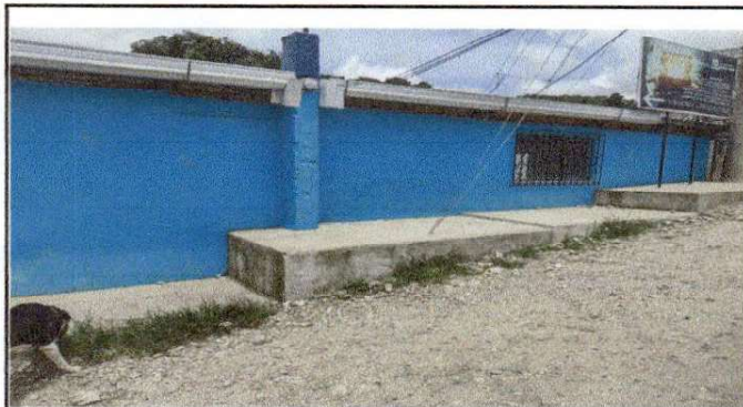
Foto 3. Hechura de banqueta de la calle
