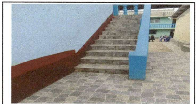
Foto 4: Instalación de pizo cerámico antideslizante en gradas lado Este
