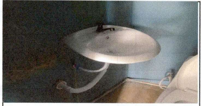
FOTO 2: Instalacion y cambio de lavamanos defectuoso
