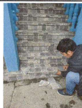
FOTO 6: Área e instalación de piso antideslizante en gradas.
