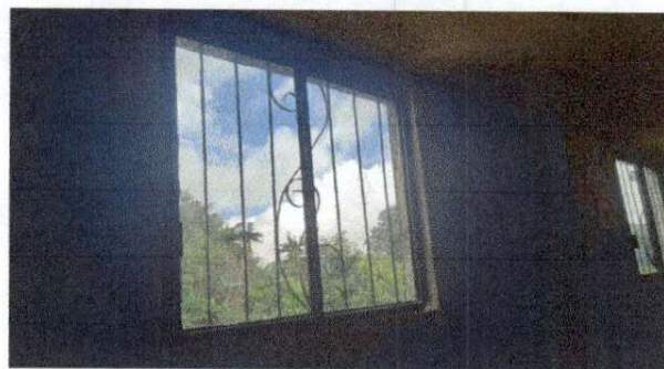
Foto 8: Sustitución de ventana.
