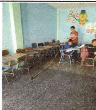
Foto 10: Colocación de piso ceramico en 2 aulas.
