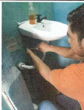
FOTO 3: Sustitución de lavamanos.
