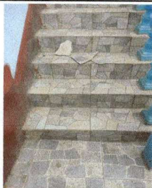
Foto 7: Área e instalación de piso antideslizante de gradas.
