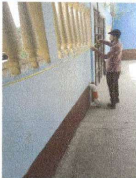
FOTO 1: Área de reparación de muro y eliminación de botellas.
