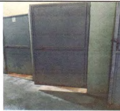
Foto 12: puertas del sanitario tanto de niños y niñas ya con óxido y evidente deterioro, las cuales serán reemplazadas.
