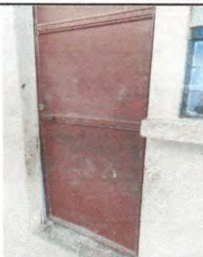
Foto 7: Puerta de aula desnivelada y deteriorada necesita ser reemplazada.
