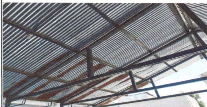
Foto 3: Falta de estructura metálica para que sirva de un mejor soporte y seguridad, ya que al momento no cumple con el mínimo de distancia entre estructuras.
