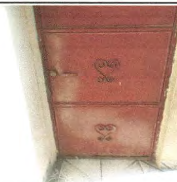
Foto 10: puerta del local de la Dirección con evidente deterioro por el óxido.
