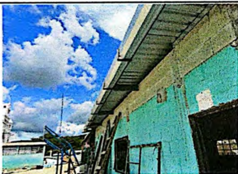
Foto 3: Suministro e instalación de canal pluvial de alto caudal en techo nuevo.
