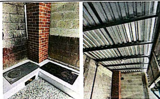
Foto 10: Fabricación de estufa de leña, con plancha metálica y chimenea de ladrillo.
