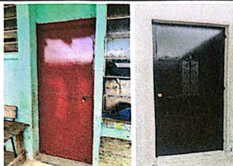
Foto 7: Mantenimiento a puertas en salones módulo B y suministro e instalación de puerta en cocina.
