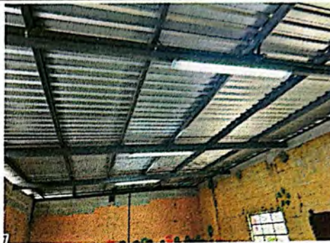
Foto 2: Se realiza el armado de techo, con estructura metálica y lámina, además se realiza la instalación eléctrica de iluminación y fuerza.
