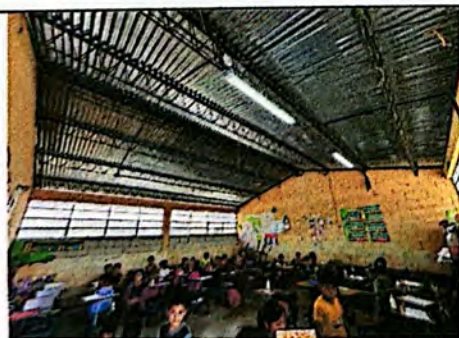
Foto 5: Se realiza el cambio en el sistema eléctrico en el módulo de aulas B incluyendo cableado, luminarias, tomacorrientes e interruptores.
