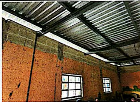
Foto 4: Se realiza el levantado de 2 hiladas de block en el perímetro del salón para mejorar la altura y minimizar el calor.
