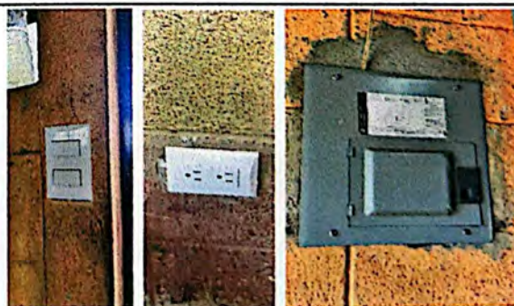
Foto 6: Se realiza la instalación de un nuevo tablero de distribución, además de colocar nuevos interruptores y tomacorrientes.
