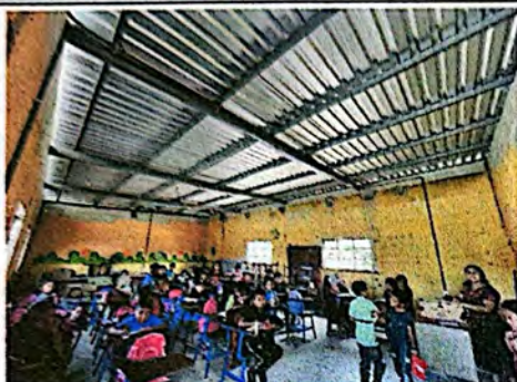
Foto 1: Suministro e instalación de estructura de soporte para techo + instalación de lámina troquelada.
