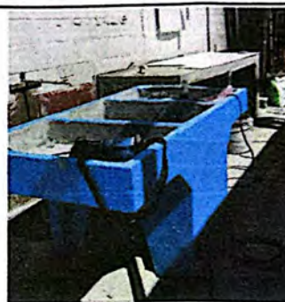
Foto 4: Suministro e instalación de pila, incluye suministro de agua potable y drenajes.
