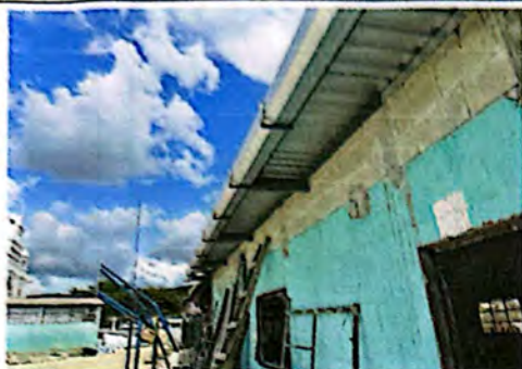
Foto 7: Suministro e instalación de canal + tubería para la descarga pluvial.
