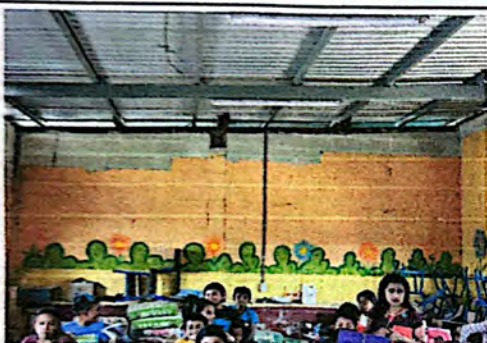
Foto 9: Aula con cambio de techo + instalación eléctrica.
