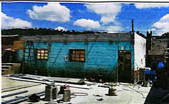
Foto 3: Se realiza el levantado de 2 hiladas de block para lograr mas altura y mitigar el calor.
