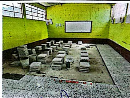
Foto 6: Suministro e instalación de piso granito en formato de 30*30 cm.
