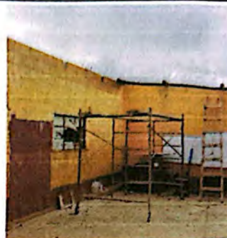
Foto 2: Se retira el techo de madera y láminas en mal estado.
