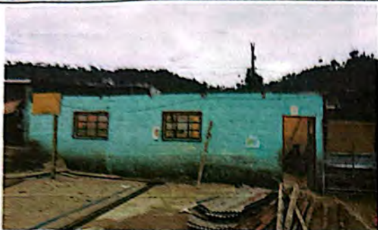
Foto 1: Desmontaje de techo en salón de clases.
