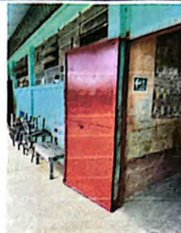
Foto 8: Mantenimiento de puertas, incluye lijado y pintura.
