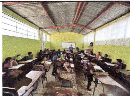
Foto 8: Salón en el cual se realizará la colocación de piso cerámico.
