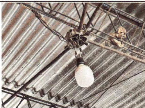
Foto 5: La instalación eléctrica de luz se encuentra expuesta y con empalmes de mala calidad por lo que representa un riesgo para los estudiantes.
