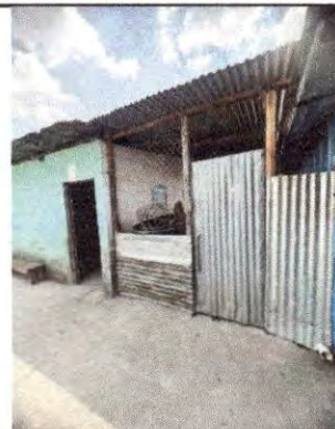
Foto 4: Los muro de cerramiento de la cocina son provisionales por lo que se deberán realizar en block.
