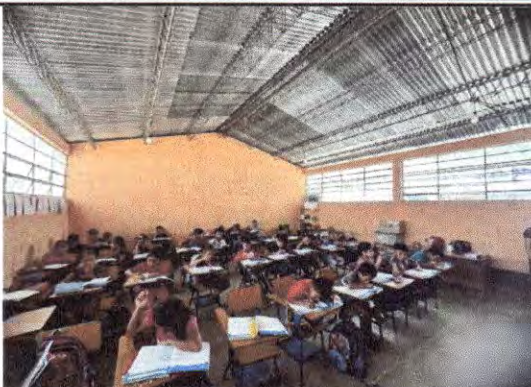
Foto 7: Se muestra uno de los salones en los que únicamente se tiene piso de concreto alisado.
