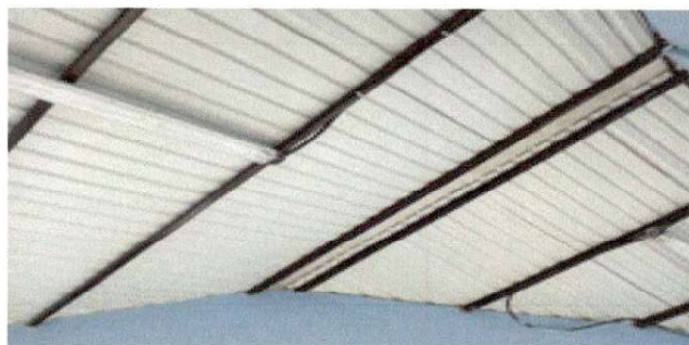
Foto 6: Mantenimiento de techo de lamina pegado y sellado con sikaflex los traslapes donde pasa agua en tiempo de invierno. Trabajo concluido.
