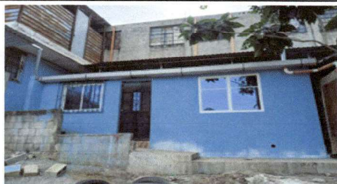
Foto 3: Ampliación de cocina en la parte de enfrente ya culminado el trabajo.
