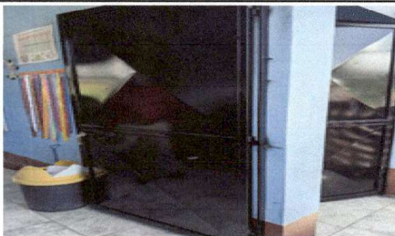
Foto 5: Mantenimiento de puertas, en esta fotografía se muestra concluido el trabajo.
