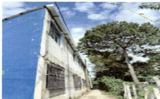
Foto 2: Parte de atrás de la escuela con canales al 100% nuevos.
