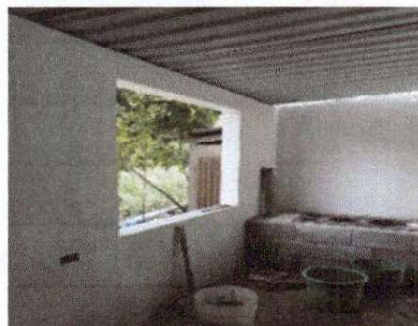
Foto 4: Esta es la parte de adentro de la cocina avanzando un 50%
