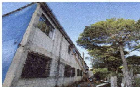
Foto 2: Parte de atrás de la escuela cambio de canales
