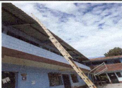
Foto 1: Frente de la escuela ya sin canales
