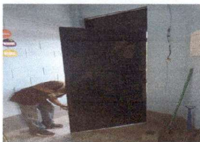
Foto 5: Mantenimiento de puertas, en esta fotografía se muestra que están lijando la puerta.
