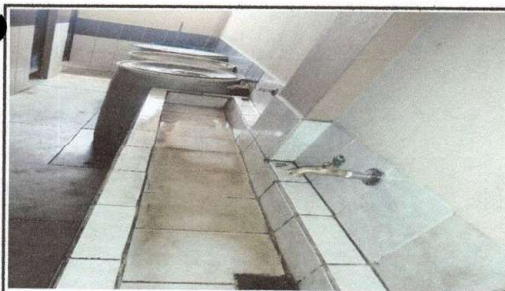
Foto 5: Módulo 5, Acá se puede observar como ha quedado la sustitución de los Chorros del lavamanos, funcionan a la perfección
