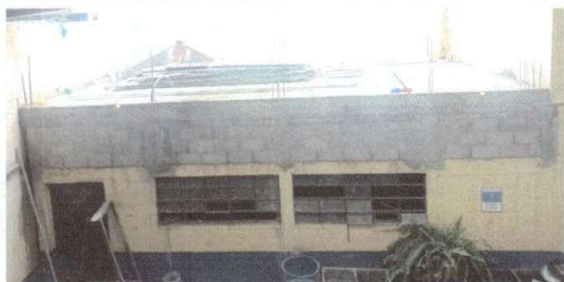
Foto 7: Techo de módulo 1, Cocina, primer nivel, losa terminada.
