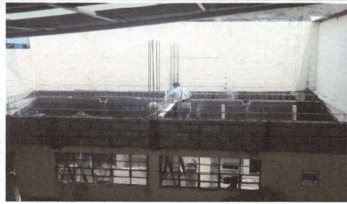
Foto 7: Módulo 1, Acá de esta preparando el módulo para colocar la losa.
