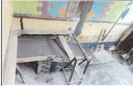
FOTO 8: Acá se esta construyendo el nuevo ingreso del establecimiento ya que por razones de seguridad de los estudiantes se decidió cambiarle de lugar al portón de ingreso.
