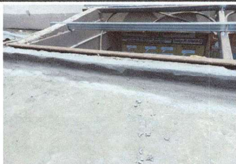
Foto 3: Techo de módulo 4, Dirección, segundo nivel, Acá se está realizando el cambio de techo.
