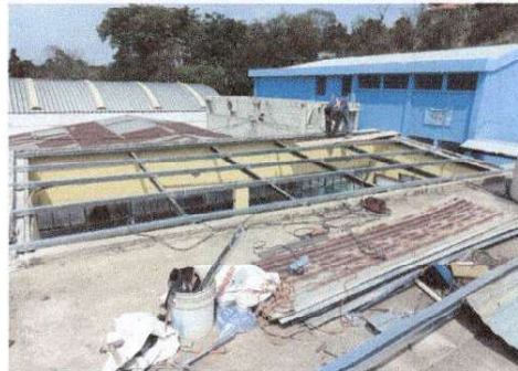
Foto 2: Techo de módulo 3, aula 2, segundo nivel, Acá se puede observar que se está cambiando el techo.
