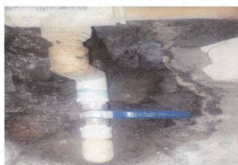
Foto 6: Acá se está realizando el cambio de llave del mingitorio, por fuga de agua.
