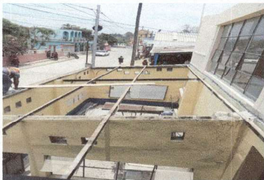
Foto 1: Techo de módulo 2, aula 1 primer nivel, Aquí se está trabajando la sustitución del techo.
