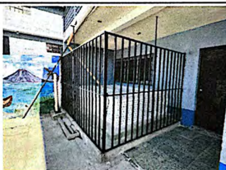
Foto 10: Suministro e instalación de rejilla para protección de pila.
