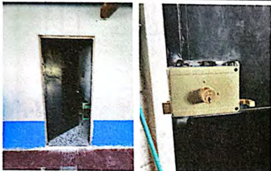
Foto 7: Mantenimiento de Puertas, incluye lijado y pintura
