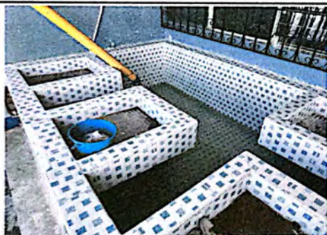
Foto 9: Aplicación de azulejo en pila de concreto.
