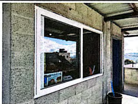
Foto 8: Instalación de ventana de UPVC doble corredizo.
