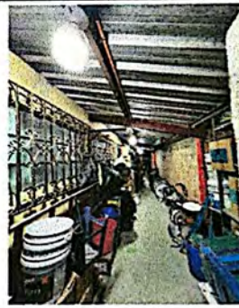
Foto 4: Instalación eléctrica de iluminación y fuerza en Bodega
