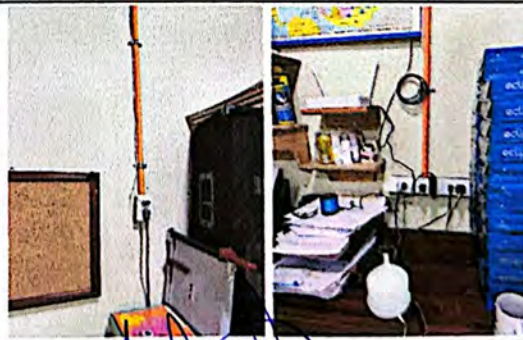
Foto 6: Suministro e instalación de tomacorrientes en Dirección.
