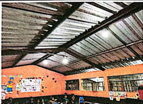
Foto 1: Suministro e instalación de sistema eléctrico, iluminación y fuerza.
