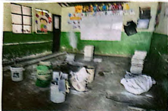
Foto 7: Suministro e instalación de piso de granito en salón de clases.
