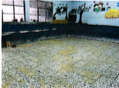
Foto 8: Instalación de piso + preparación para pulido.
