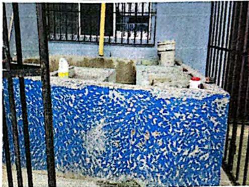
Foto 10: Preparación de pila para colocación de azulejo.
