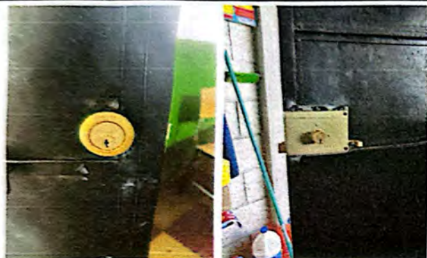
Foto 9: Sustitución de chapa en puerta de salón.
