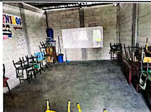
Foto 6: Salón en Módulo C, sin piso.
