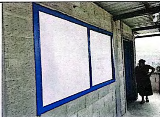
Foto 9: Se realizará la aplicación de pintura en 2 salones del Módulo C, en el interior y exterior.
