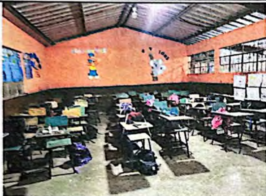
Foto 1: Salón de Bloque B en el cual se colocará piso.
