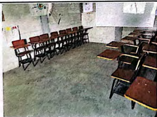
Foto 5: En el Módulo C no se cuenta con piso, por lo que se le colocará a los salones.
