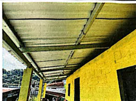
Foto : Cambio de estructura de soporte en techo, mas instalación de lámina troquelada.
