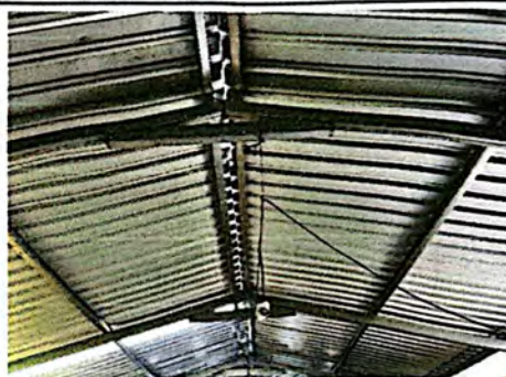
Foto 10: Suministro e instalación de techo de lámina en cocina, se verifican los traslapes.
