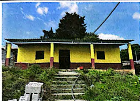
Foto 7: Aplicación de pintura exterior en cocina.
