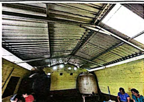
Foto 9: Suministro e instalación de techo de lámina en cocina.
