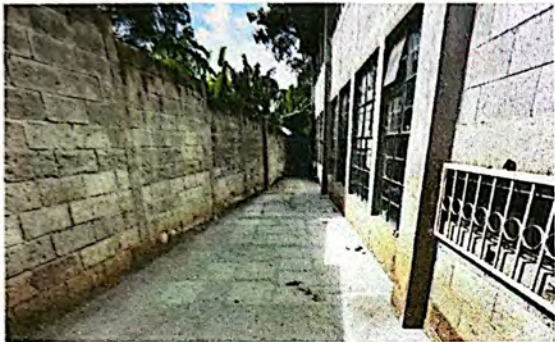
Foto 1: Fundición de torta de cemento en parte posterior de la escuela.
