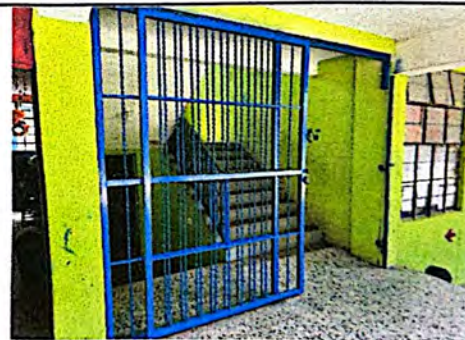
Foto 10: Suministro e instalación de puerta tipo rejilla.
