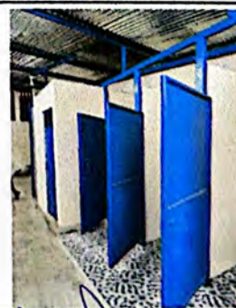
Foto 6: Suministro e instalación de puertas para baños
