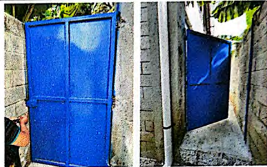
Foto 2: Mantenimiento a puerta metálica, incluye ajuste, lijado y pintura.
