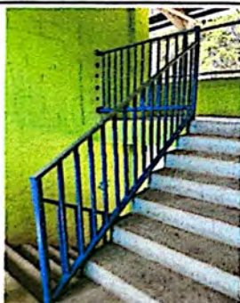
Foto 9: Instalación de barandilla en módulo de gradas incluye pintura.
