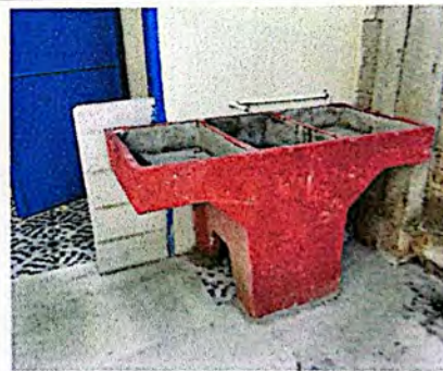
Foto 4: Suministro e instalación de pila.
