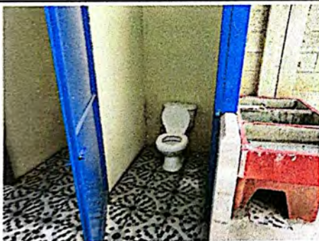
Foto 3: Suministro e instalación de inodoros + instalación de piso antideslizante + Muro pinatado para baño.
