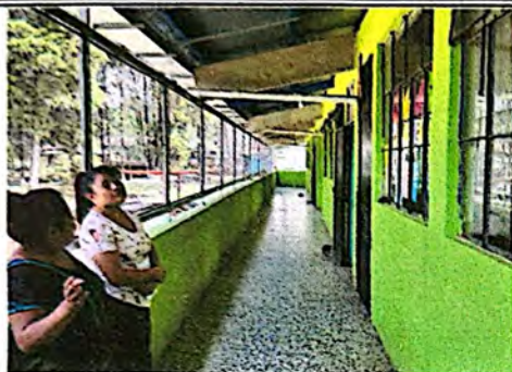
Foto 7: Instalación de marcos metálicos con malla, para evitar el riesgo de que los niños puedan caer.
