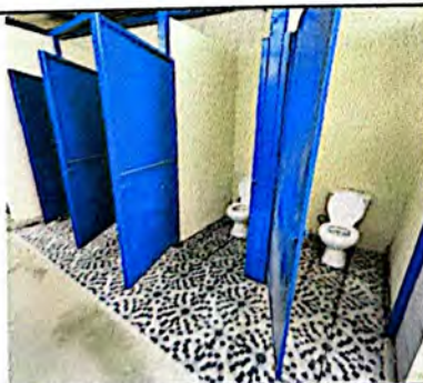
Foto 5: Suministro e instalación de puertas metálicas para baños.
