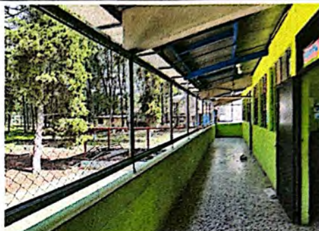
Foto 8: Se verifica que la estructura metálica que conforma los marcos se encuentre bien anclada.
