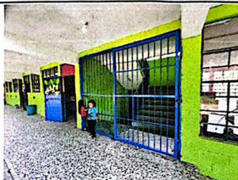
Foto 10: Suministro e instalación de puerta tipo rejilla.
