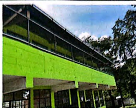
Foto 8: Se verifica que la estructura metálica que conforma los marcos se encuentre bien anclada.
