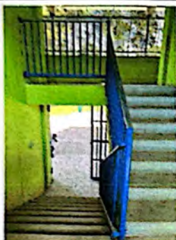
Foto 9: Instalación de barandilla en módulo de gradas incluye pintura.
