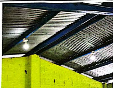
Foto 3: Suministro e instalación de luminarias.
