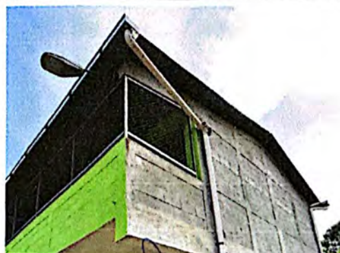
Foto 6: Suministro e instalación de tubería para descarga pluvial.
