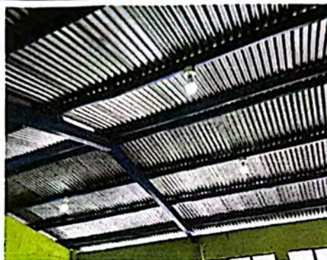
Foto 2: Instalación eléctrica de iluminación.
