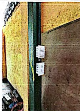
Foto 4: Instalación de tomacorrientes e interruptores.
