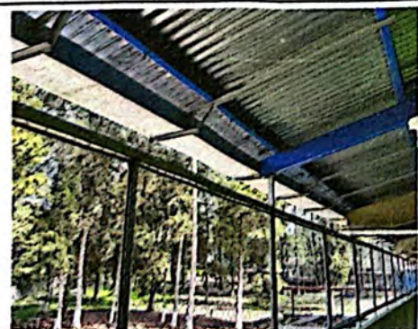
Foto 5: Instalación de canal pluvial de alto caudal.
