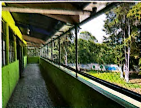
Foto 7: Instalación de marcos metálicos con malla, para evitar el riesgo de que los niños puedan caer.
