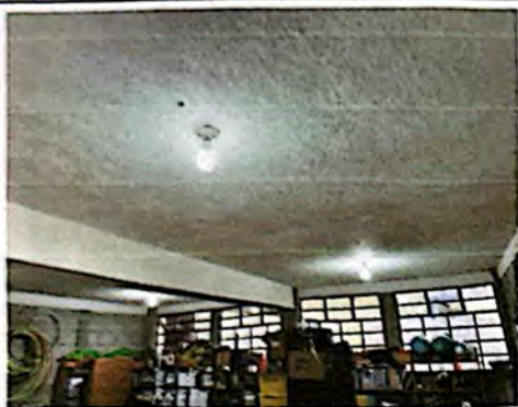
Foto 1: Suministro e instalación eléctrica de iluminación
