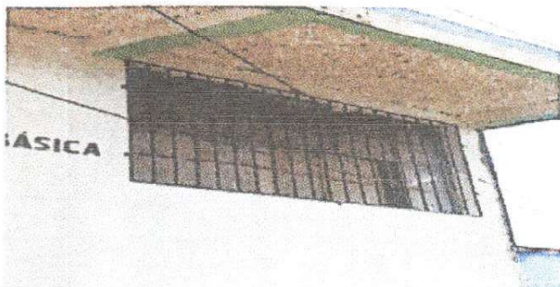
Foto 1: Instalacion de estructura metalica
