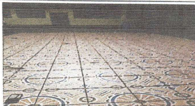
Foto 2: Finalizacion de instalacion de piso.
