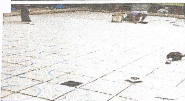
Foto 5: Ultimos detalles de la colocacion de piso en el patio
