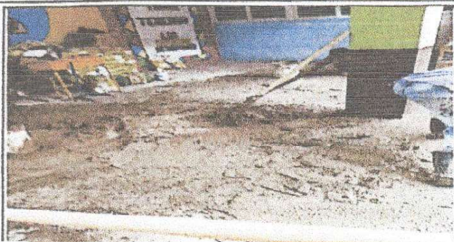
Foto 1: Inicio de trabajo de colocacion de piso en patio.
