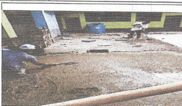
Foto 2: Proceso de colocacion de piso en patio.
