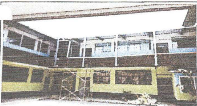
Foto 5: intermedia de colocacion de techo en patio.
