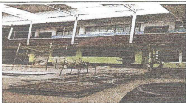
Foto 3: Proceso de colocacion estructura metalica de techo
