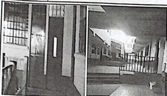
Foto 7: pintura en muros interiores y puertas de salones
