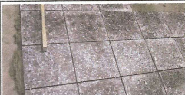
Foto 5: instalación de piso de granito en bodega
