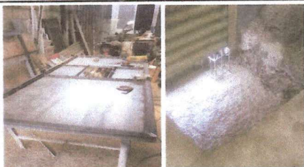
Foto 1: Fabricación de portón para entrada principal, fundición de cimientos para instalar portón
