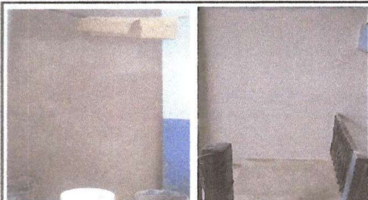
Foto 7: resane de paredes
