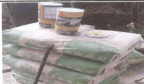
Foto 4: nueva capa de loza e impermeabilización de la misma.
