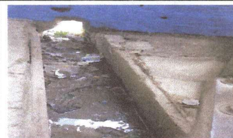
Foto 12: reparación de salida de agua pluvial interna
