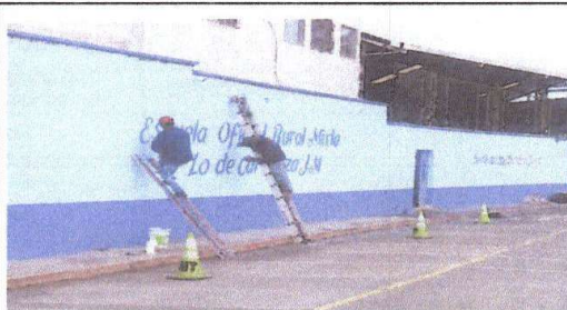
Foto 10: Aplicación de pintura en muros exteriores
