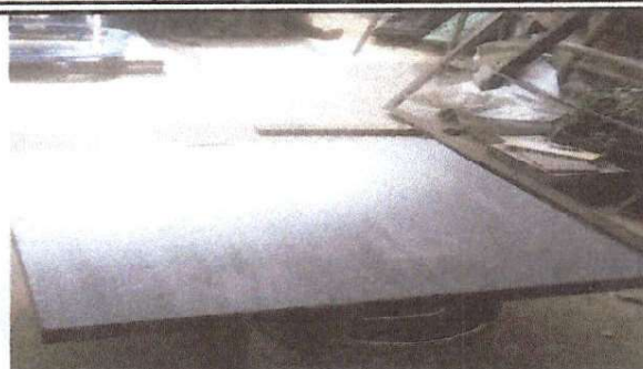
Foto 2: Elaboración de tapa metálica para cisterna
