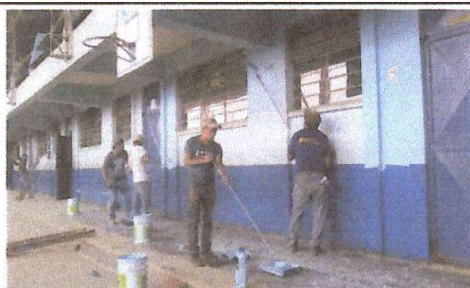
Foto 9: aplicación de pintura en muros interiores de escuela
