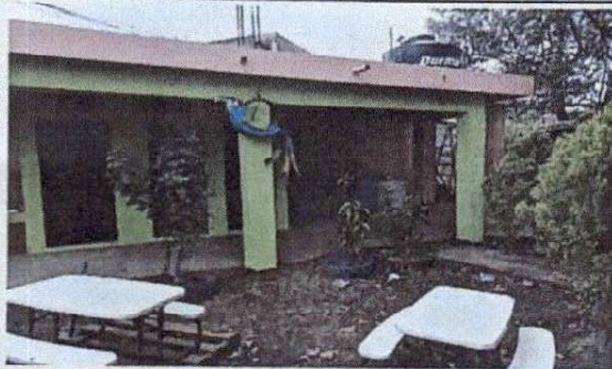
Foto 3: pintura de modulo de baños.
