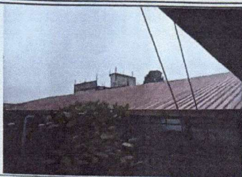
Foto 1: instalación de lámina y estructura nueva de 3 aulas del módulo de preprimaria
