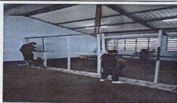
Foto 4: Pintura y preparacion del interior de las aulas
