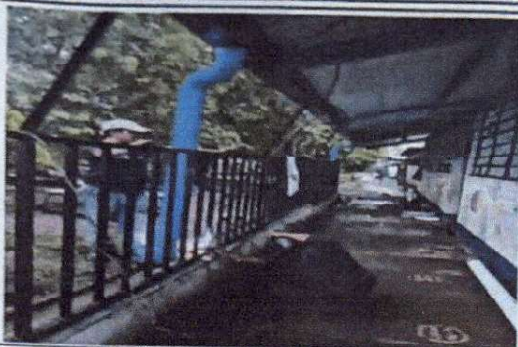
Foto 1: montado e instalación de bajadas de aguafluvial del módulo de preprimaria
