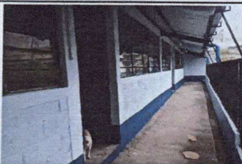
Foto 5: Pintura exterior de las aulas
