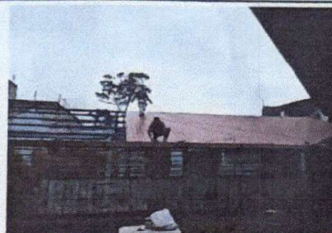
Foto 2: Instalación de lámina y estructura nueva de 3 aulas del módulo de preprimaria
