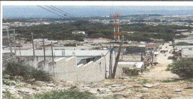
Foto 2: Se observa el trabajo finalizado del remozamiento del area lateral del establecimiento
