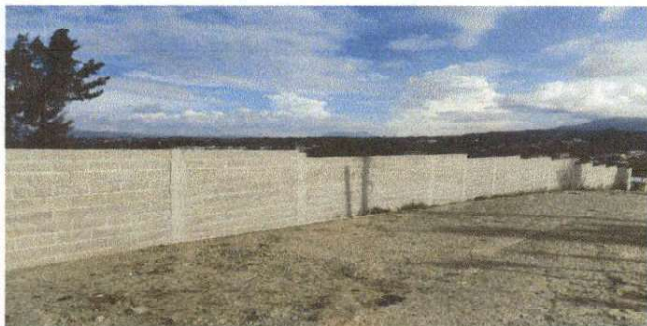
Foto 1: Parte superior de la escuela en la que se aprecia el muro perimetral del remozamiento; brindándole seguridad a la institución.
