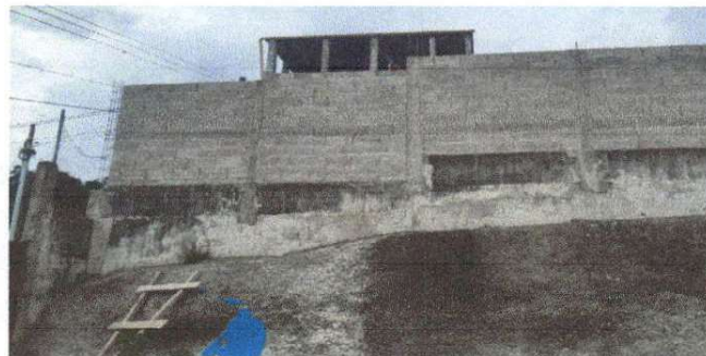
Foto 4: Vista interna del perímetro superior de remozamiento realizado en la escuela
