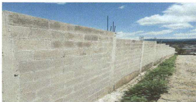
Foto 3: Vista finalizada del muro perimetral de la parte superior de la escuela que comprende 60 metros de largo.
