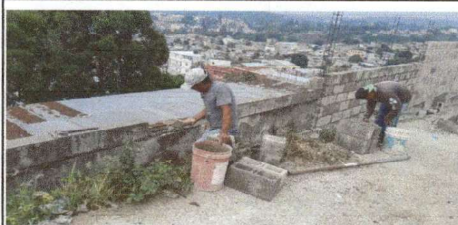
Foto 2: Cerco perimetral del establecimiento retirado para instalar el multiblock
