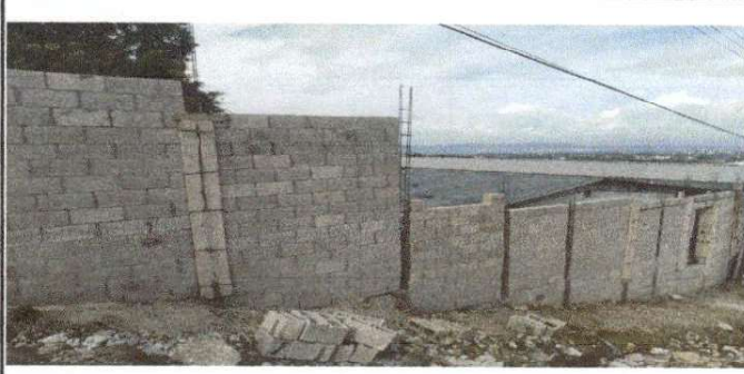
Foto 6: Avance del remozamiento del perimetral de la escuela, que colinda con el callejón
