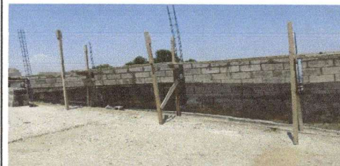
Foto 4: Se aprecia el levantado de la pared en el perímetro del establecimiento.
