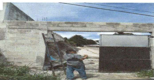
Foto 5: Se observa de el remozamiento del portón con la continuidad de muro sugerido por el técnico
