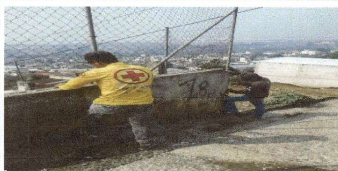
Foto 1: Parte superior de la escuela Margaritas; se aprecia el inicio del remozamiento moviendo la estructura metálica con malla.
