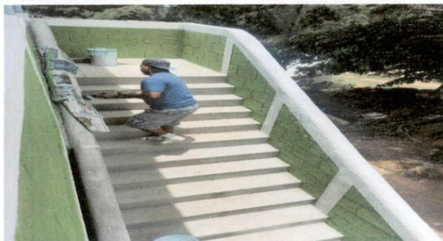
Foto1: Final del pasamanos del segundo nivel.
