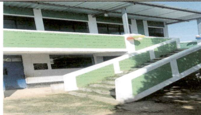
Foto 4: Segundo nivel ejecutado y terminado.
