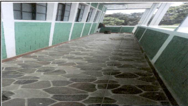
Foto 3: Trabajo final del pasillo del segundo nivel zócalo, piso y pintada.
