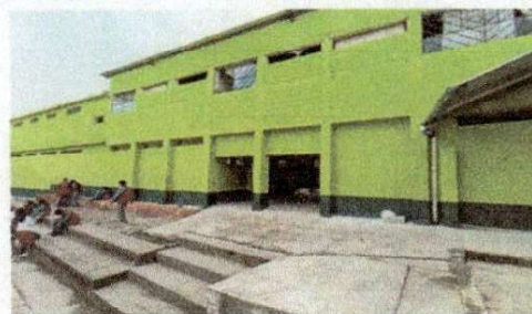
Foto 2: En esta imagen se muestra la pared A a trabajar en el primer nivel: repellado, cernido y pintura- polideportivo del establecimiento. Iniciando el trabajo.
