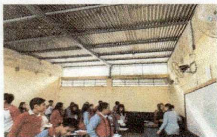
Foto 5: En esta imagen se muestra el salon 4 según croquis, con trabajos finalizado del levantado de techo para mejorar la ventilación en salón de tercero básico Sección D. (vista de afuera hacia adentro)
