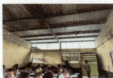
Foto 6: En esta imagen se muestra el salon 5 según croquis, con trabajos finalizados del levantado de techo para mejorar la ventilación en salones de tercero básico Sección C (vista de adentro hacia afuera).
