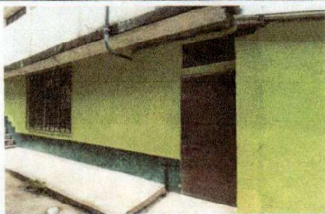
Foto 3: En esta imagen se muestra la pared B a trabajar en el primer nivel oficina Escuela de Comercio pared exterior: se muestra el proceso del trabajo.
