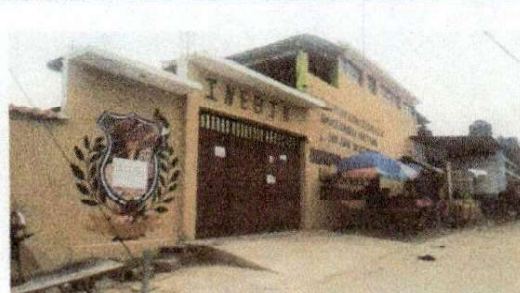
Foto 4: En esta imagen se muestra la pared c a trabajar en la entrada lateral de establecimiento sobre la 2a. Calle zona 2.
